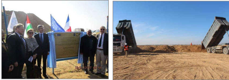
شكل 12. صور عن أعمال الحفر في المكب الجديد في منطقة الفخاري
